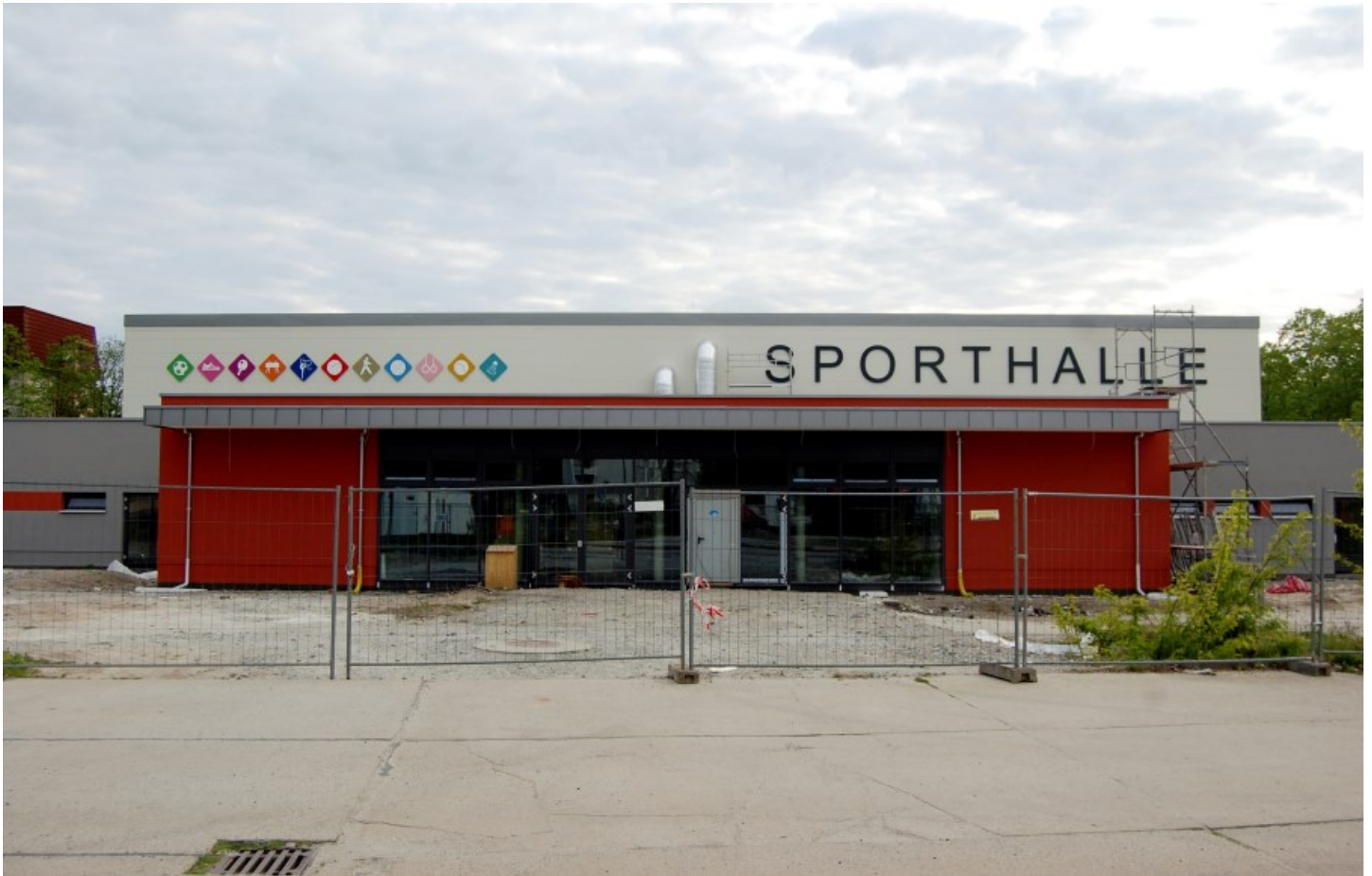
Der Rohbau ist längst beendet, die Funktion schon ablesbar. Fotos (2): Mirko Kolodziej
