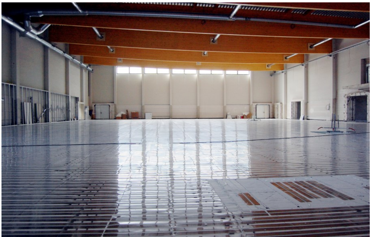
Zwischen Fußbodenheizung und Fischbauch-Bindern liegen sieben Meter.
